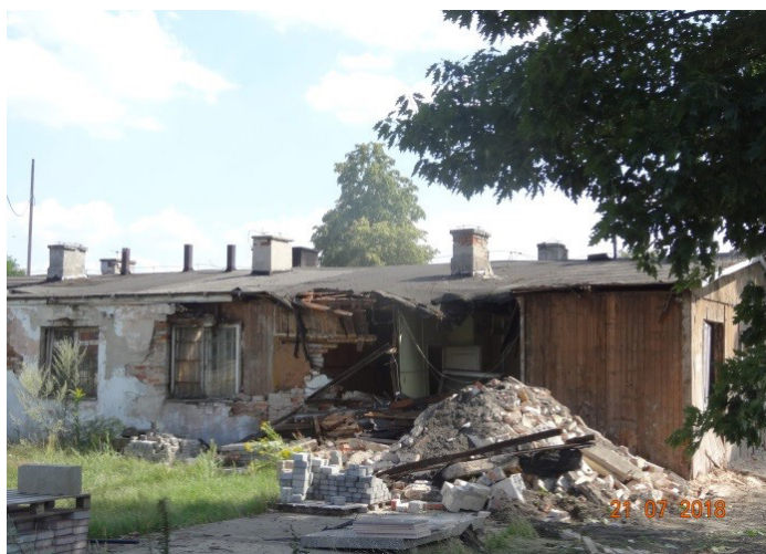
Rozbiórka baraku misji angielskiej, który był jednym z dawnych budynków Urzędu Gminy, 21 lipca 2018 r. (fot. A. Olechowski)
