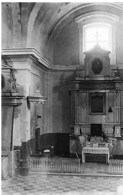
Wnętrze nieporęckiego kościoła. Widoczne osmalone sklepienia, spalony boczny ołtarz i ambona, po której pozostał jedynie daszek, 1945 r. (arch. J. Szczepańskiego)
