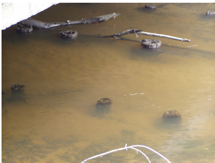
Ślady podpór pierwszego mostu (fot. M. Borkowski)
