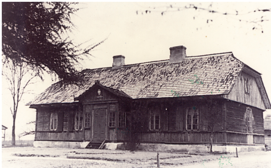
Drewniany budynek szkoły tzw. Dworek (arch. W Bławdziewicza)
