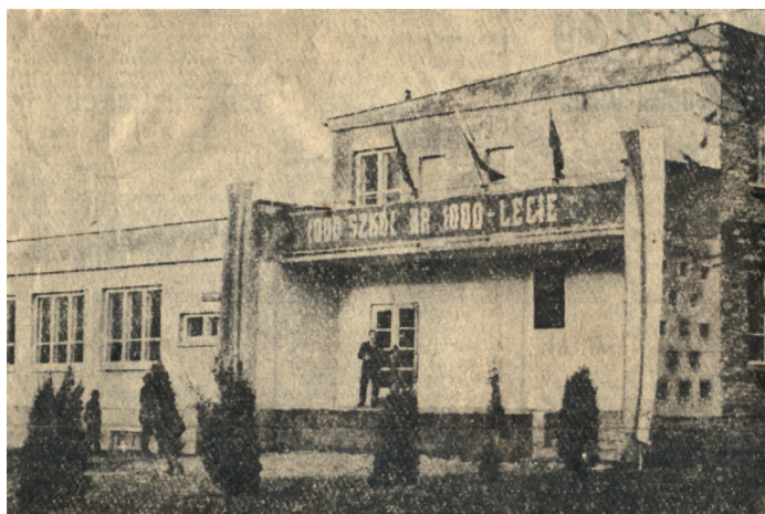
Nowy budynek szkoły (arch. SP Izabelin)
