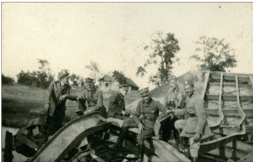
Zniszczony most na Narwi, 1920 r. Miejsce nieustalone (PiM im. gen. Sikorskiego w Londynie, sygn. IS_15-20_116_580)
